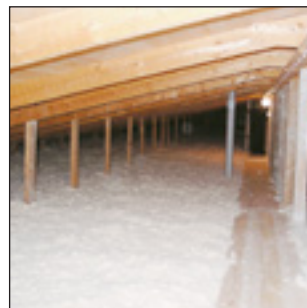
Efter tilläggsisolering med träfiber. Klart!
