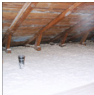
Efter tilläggsisolering med träfiber. Klart!
