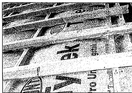
Figur 3: Resultat av blåsning med tre extraläkt. Fortfarande trycks underlagstaket mot bärläkten.
