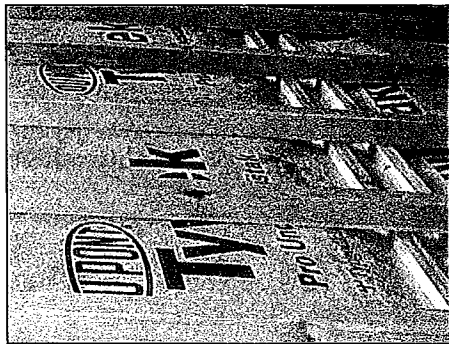
Figur 2: Resultat av blåsning utan extraläkt. Underlagstaket trycks mot bärläkten och vattenavledningen hindras.
